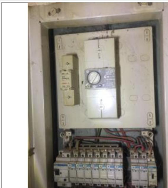
Appareil général de commande et de protection réglé à 30A, non alimenté
