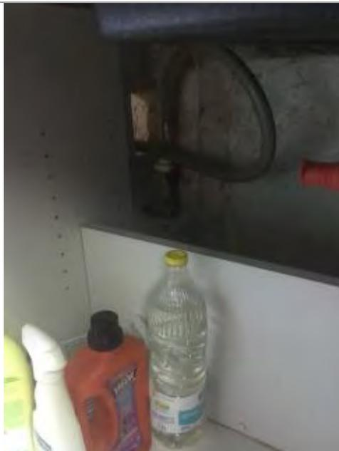
Plaque encastrée alimenté par un tube type gazinox
