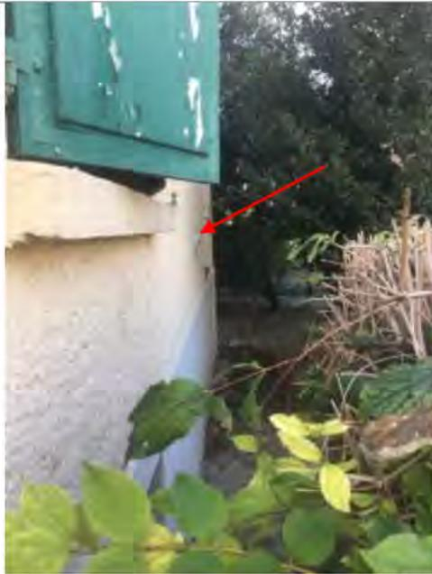
Débouché extérieur des gaz de combustion du radiateur étanche visible et dégagé
