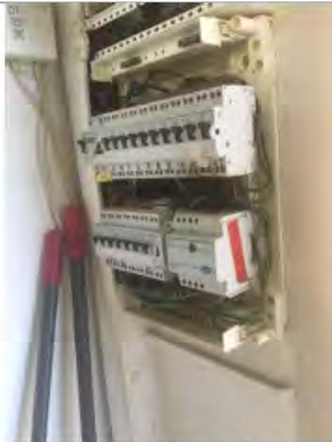
Tableau de répartition: présence d'un dispositif de protection haute sensibilité 30mA/40A
