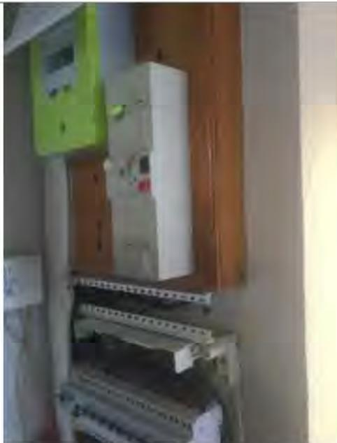
Appareil général de commande et de protection réglé à 45A non alimenté
